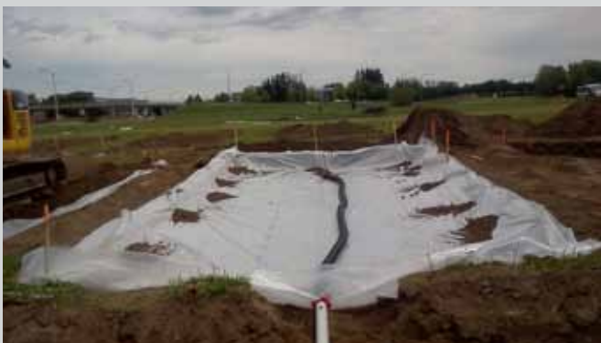
Parcelle excavée dotée d'un revêtement en plastique au fond et d'un tuyau de vidange pour recueillir les eaux de lessivage
